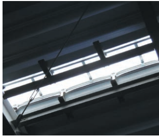
▲断熱屋根用 ワイド500 単板ガラス+中空シート(乳白)仕様 ※妻タイトピッチ調整施工
