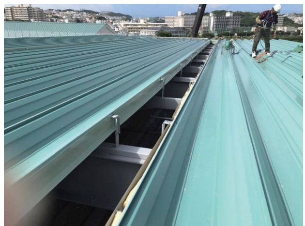
▲断熱屋根用 ワイド500 単板+中空シート(クリア)仕様 ※妻タイトピッチ調整施工
