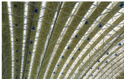
◀シングル屋根用 ワイド500 単板+中空シート(クリア) R屋根対応型(オプション)
