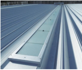
▲断熱屋根用 ワイド500 単板ガラス+中空シート(乳白)仕様 ※妻タイトピッチ調整施工
