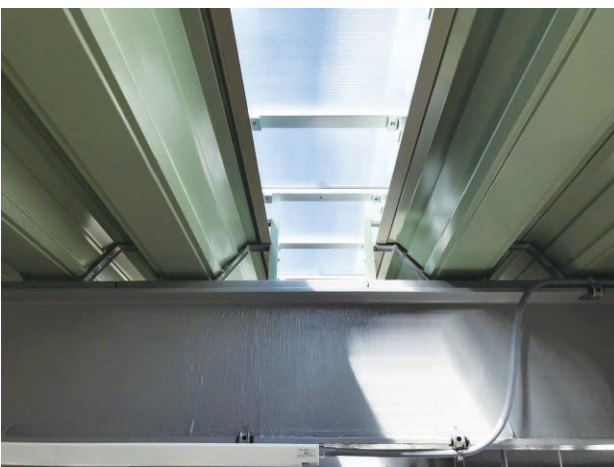
▲断熱屋根用 ワイド500 単板+中空シート(クリア)仕様 ※妻タイトピッチ調整施工
