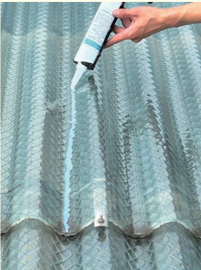
ひび割れ部に沿ってHS 充填
