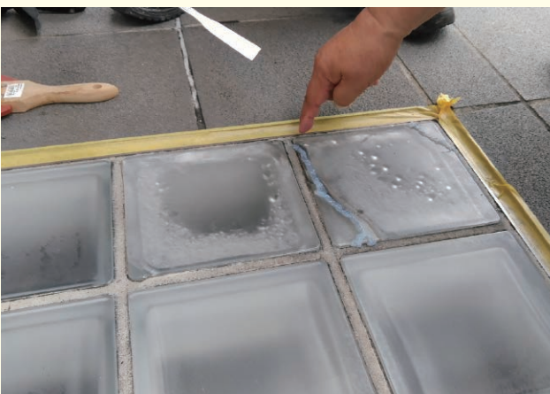
ひび割れ部に沿ってHS 充填
