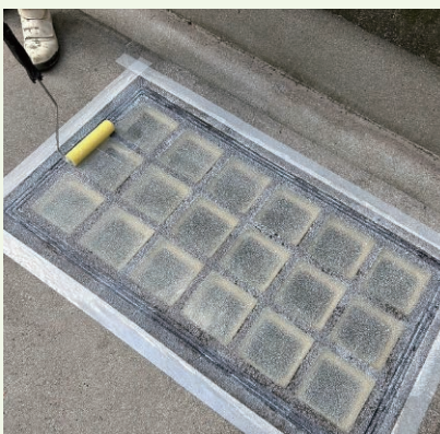
耐水コートを砂骨ローラー塗装
