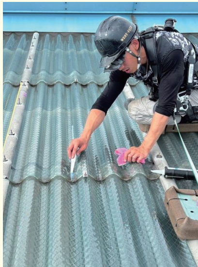
充填後のヘラ押え作業
