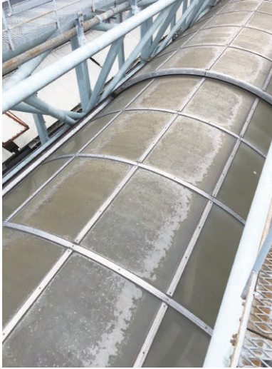
改修前 トップライト外観
